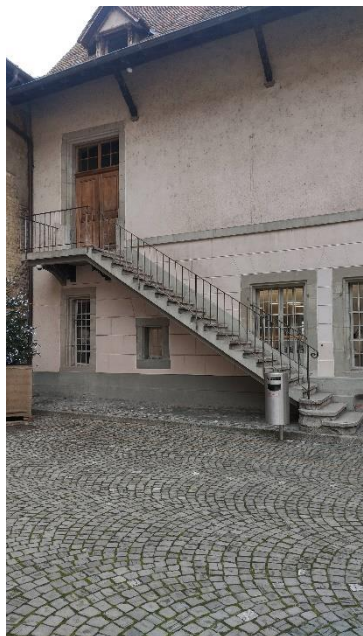
L'escalier du château
